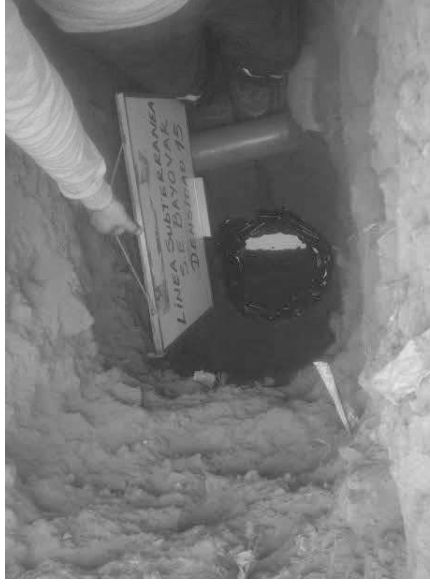
Foto 62. Prueba de densidad de calicata 15
