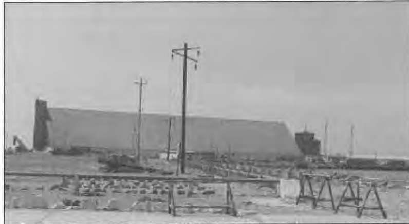
Figura 3.5-13 – Vista del almacén 2 del Terminal Portuario de Salaverry desde el exterior
