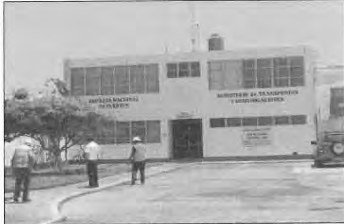
Figura 3.5-15 – Vista del edificio administrativo del Terminal Portuario de Salaverry
