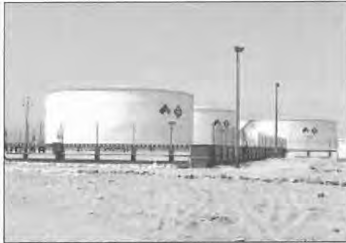
Figura 3.5-20 – Vista general de uno de los tanques de la planta Coazucar del Perú
