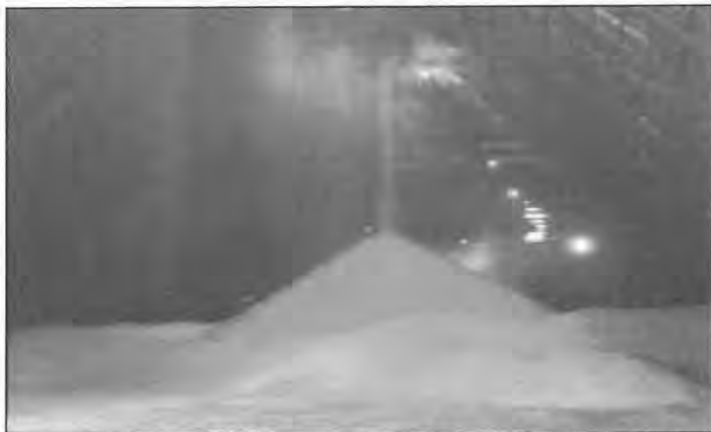
Figura 3.5-14 – Vista del almacén 2 del Terminal Portuario de Salaverry desde el interior
