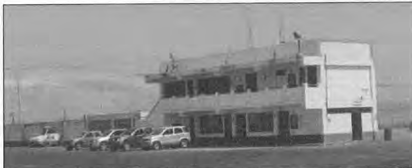
Figura 3.5-16 – Vista del edificio operativo
