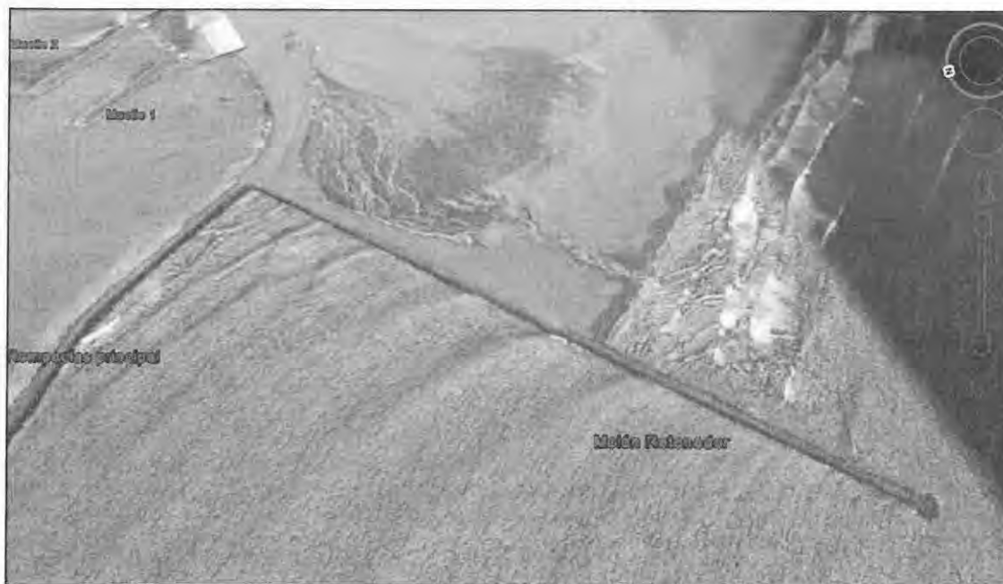
Figura 3.5-10- Vista general del Molón retenedor del Terminal Portuario de Salaverry
