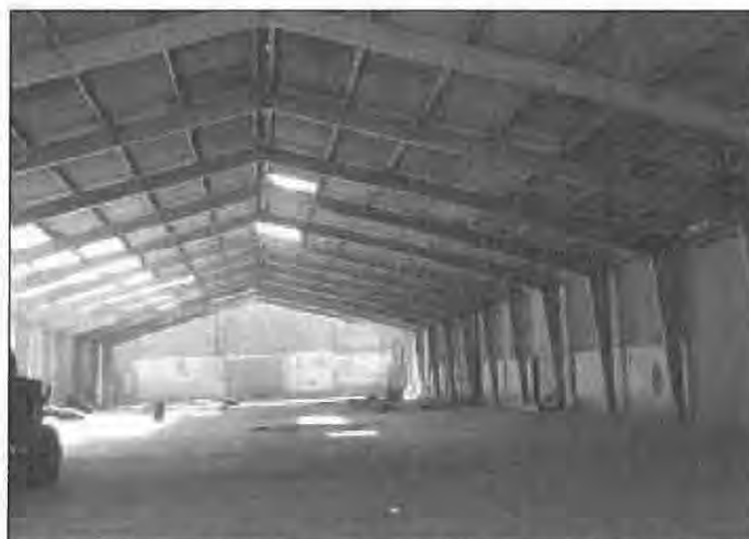
Figura 3.5-12 – Vista del almacén 1 del Terminal Portuario de Salaverry desde el interior
