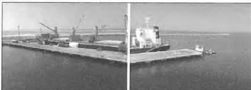
Figura 3.5-2 - Vista general del Muelle 1 del Terminal Portuario de Salaverry
