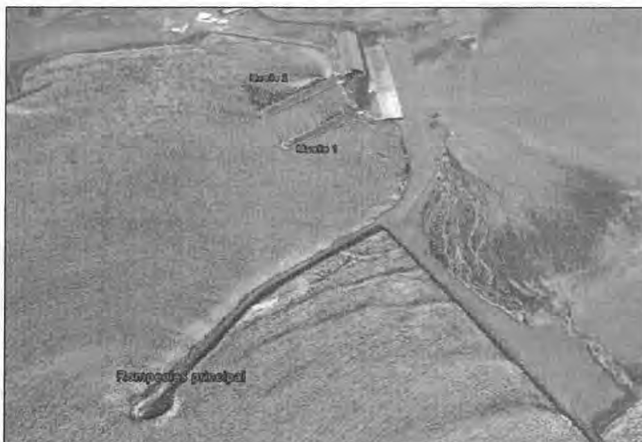
Figura 3.5-9 – Vista general del rompeolas principal del Terminal Portuario de Salaverry
