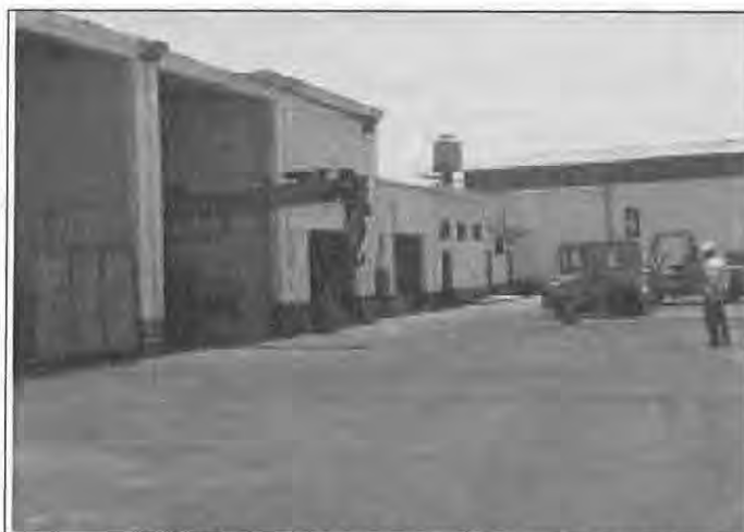
Figura 3.5-17 – Vista de área de mantenimiento y servicios
