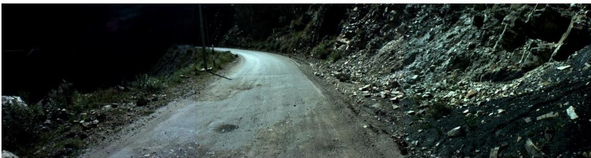
Km 396+000, Se aprecia pavimento con huecos en malas condiciones.
