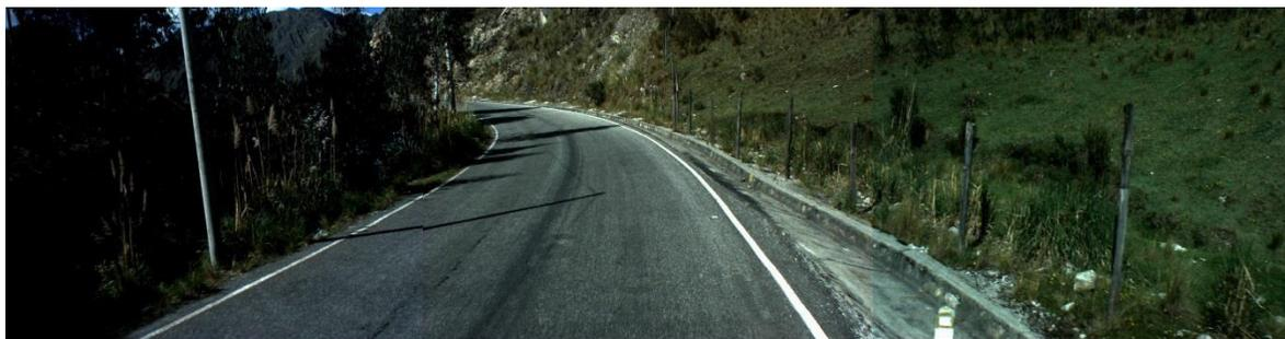
Km 392+200, se aprecia superficie de rodadura desgastada, borde de plataforma con erosión por drenaje.
