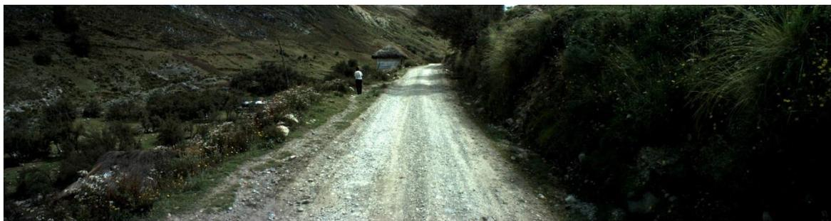
Km 44+520, Se aprecia superficie de rodadura desgastada.
