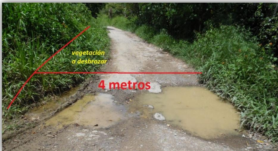
Figura N° 03: El ancho existente cubre el ancho de calzada (entre Santa Rosa y Los Naranjos)
