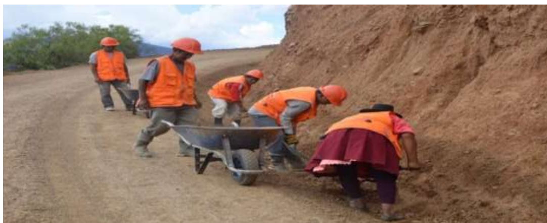
Foto N° 03.- Trabajo típico en mantenimiento de camino vecinal.
