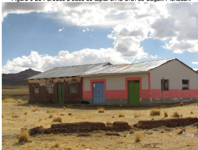
Figura 3-25 Paredes a base de tapial en la C.C. de Cagalli Pichacani
