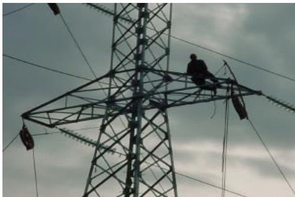
Fotografía ¡Error! No hay texto con el estilo especificado en el documento.-7 Extendimiento del hilo piloto
