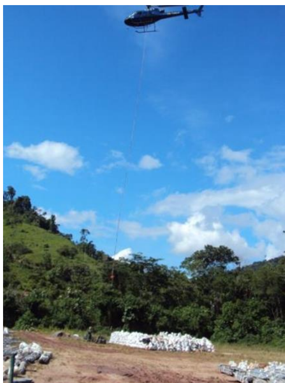
Fotografía ¡Error! No hay texto con el estilo especificado en el documento.-3 Helicóptero preparando el enganche de la carga y transporte agregado
