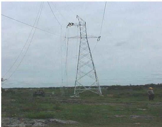
Fotografía ¡Error! No hay texto con el estilo especificado en el documento.-9 Colocación de grapas.
