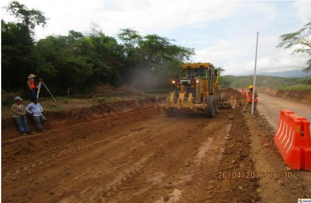
Fotografía N° 10.- Vista fotográfica motoniveladora en perfilado y conformación de terraplenes.
