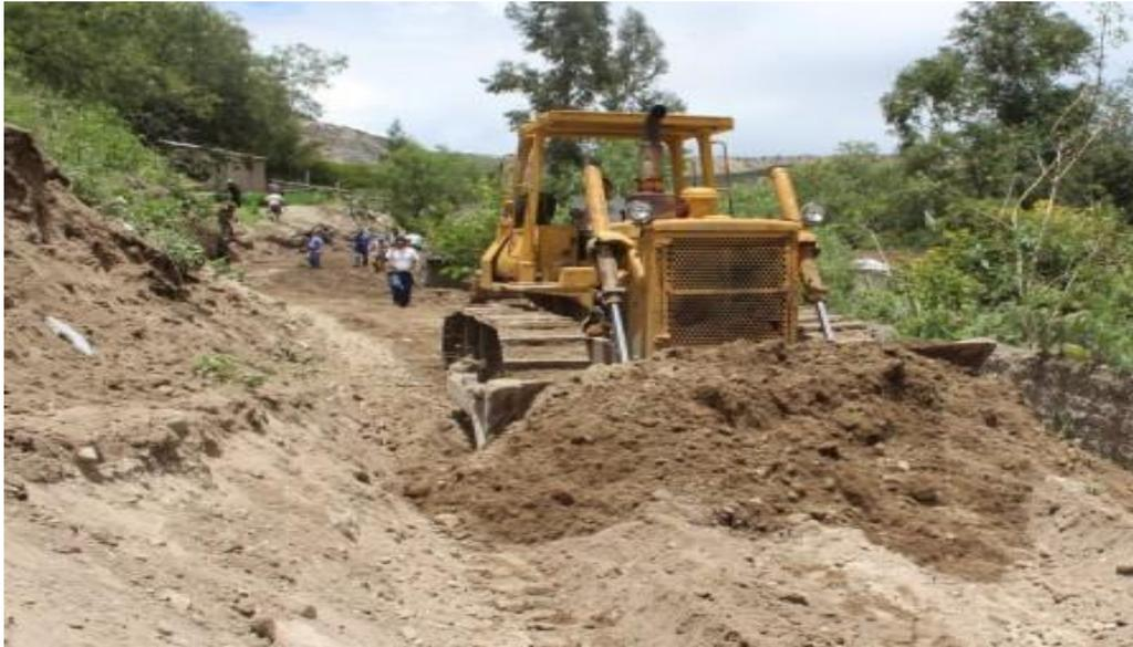
Fotografía N° 20.- Movimiento de tierras: corte de material suelto
