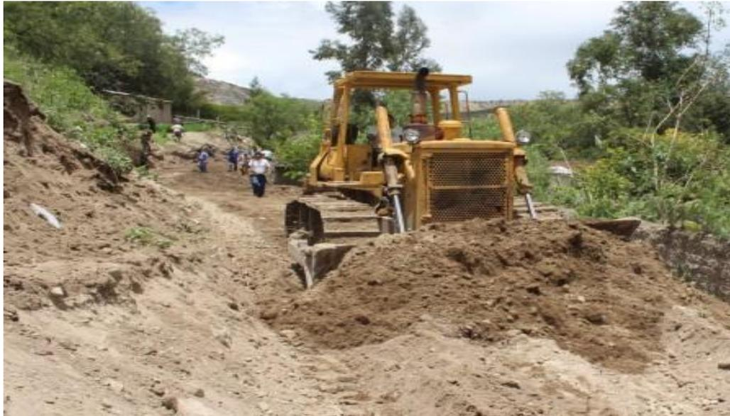
Fotografía N° 07.- Corte de material suelto
