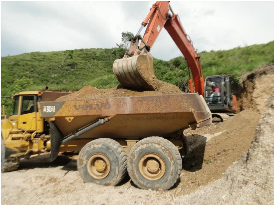
Fotografía N° 11.- Maquinaria usada en eliminación de material excedente
