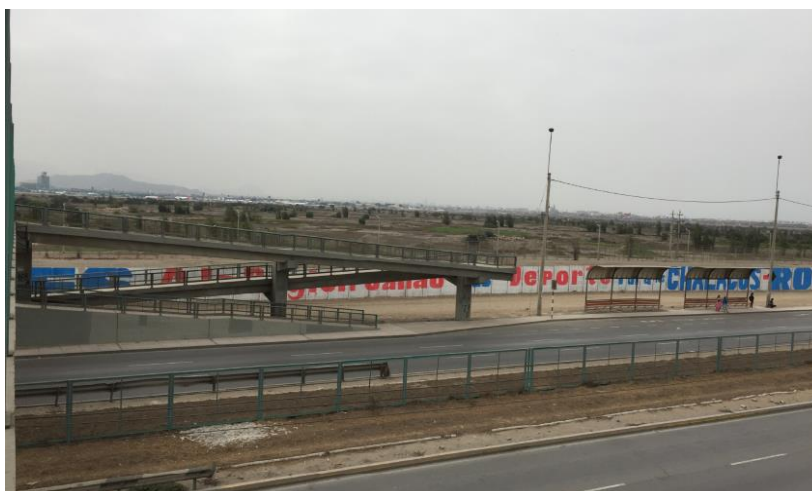
Fotos 2 , Av. Néstor Gambeta con ausencia de áreas verdes, la infraestructura vial presenta colores de poco contraste visual.
