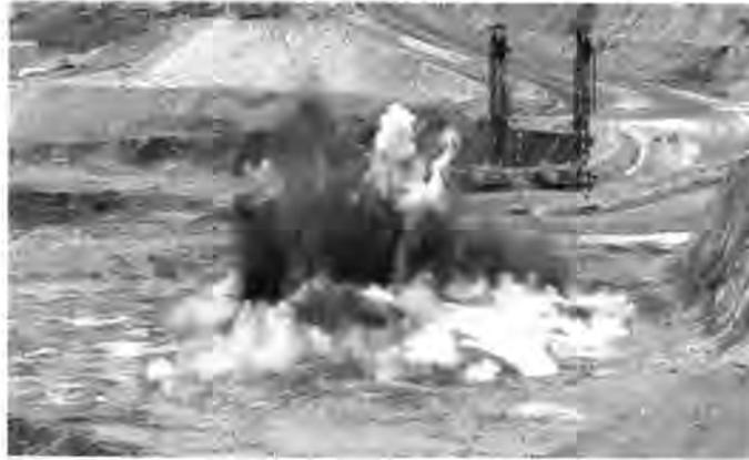
**Figura 1: Voladura primaria en el tajo Ferrobamba, producto del disparo se levanta polvo, gases, ruido y vibración del suelo.**
