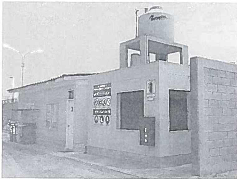
Fotografía N° 6: Vista del Tanque de Agua el cual se encuentra implementada y listo para su funcionamiento.
