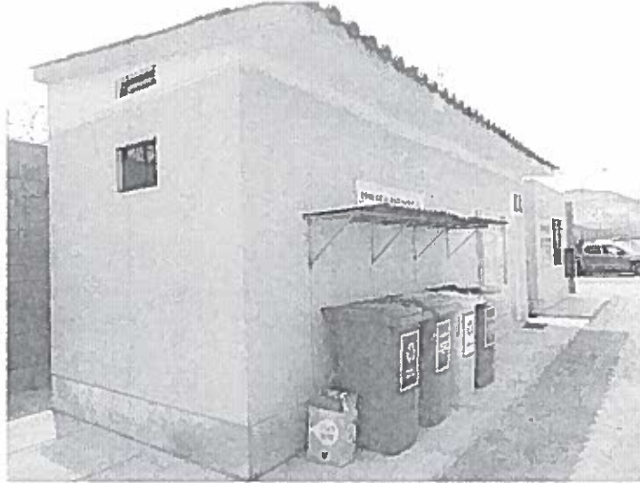
Fotografía N° 3: Vista panorámica exterior del área de los servicios higiénicos el cual se encuentra totalmente construido.
