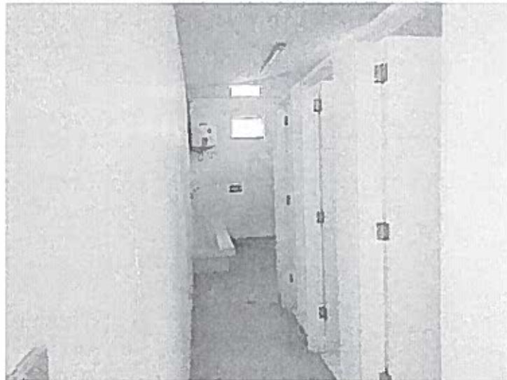
Fotografía N° 4: Vista interior de los servicios higiénicos los cuales se encuentran con todos los acabados culminados listos para entrar en funcionamiento.
