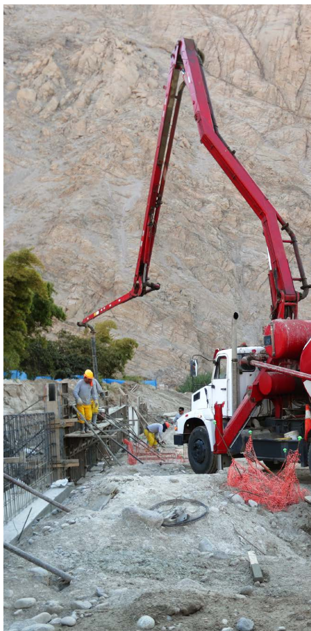
Foto: Ministerio de Vivienda, Construcción y Saneamiento.
