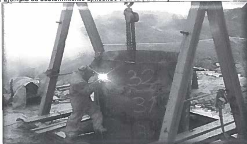
Figura 11. Ejemplo de sostenimiento aplicando anillos para mejora la estabilidad de la excavación.
