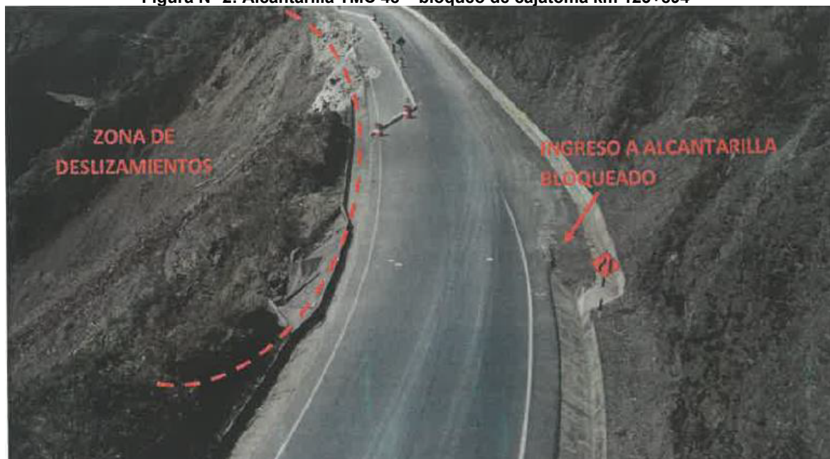
Figura N° 2: Alcantarilla TMC 48"- bloqueo de cajatoma km 123+894
