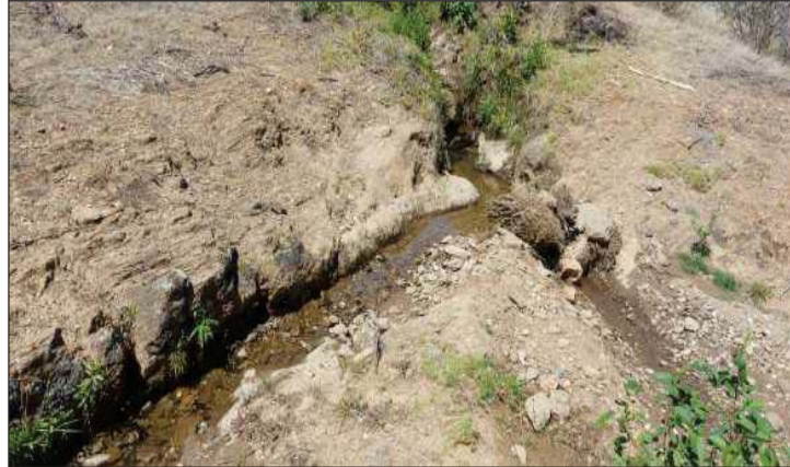
Fotografía 01: Cruce de acceso con canal de riego
