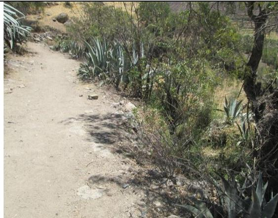
Foto 05: Tramo km. 0+470 al km. 0+510, al lado derecho canal de riego a desnivel considerable. En lado izquierdo se debe construir cuneta.
