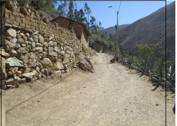
Foto 04: Tramo km. 0+120 al km. 0+160. Se observa el poste eléctrico. Las cunetas serán a media ladera (solo a un lado).
