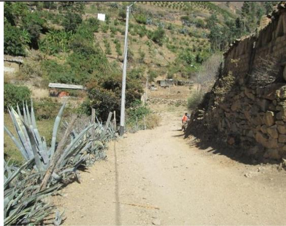
Foto 03: Vista del tramo km. 0+080 al km. 0+120 con camino de herradura de ancho promedio de 3.00m
